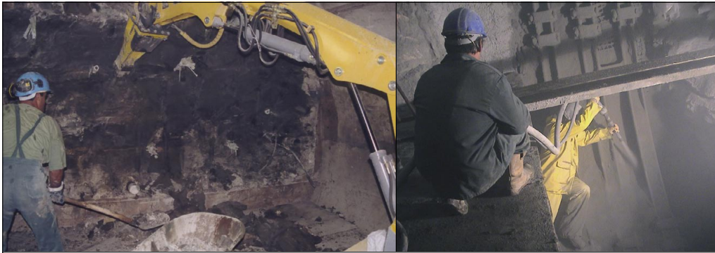
↑ Figuur 7 Constructie van de montagekamer.
